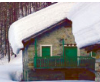
C7-02 Neve su tetto
